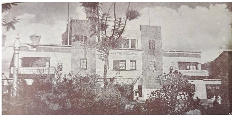
Edificio Nacional de Correos y Telégrafos frente al Parque Benjamín Herrera Bucaramanga.
